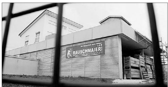
Ein überdachtes Gerüstlager mit Büro, Sozialräume und eine Betriebswohnung gibt es am neuen Standort der Firma Rauschmaier.
